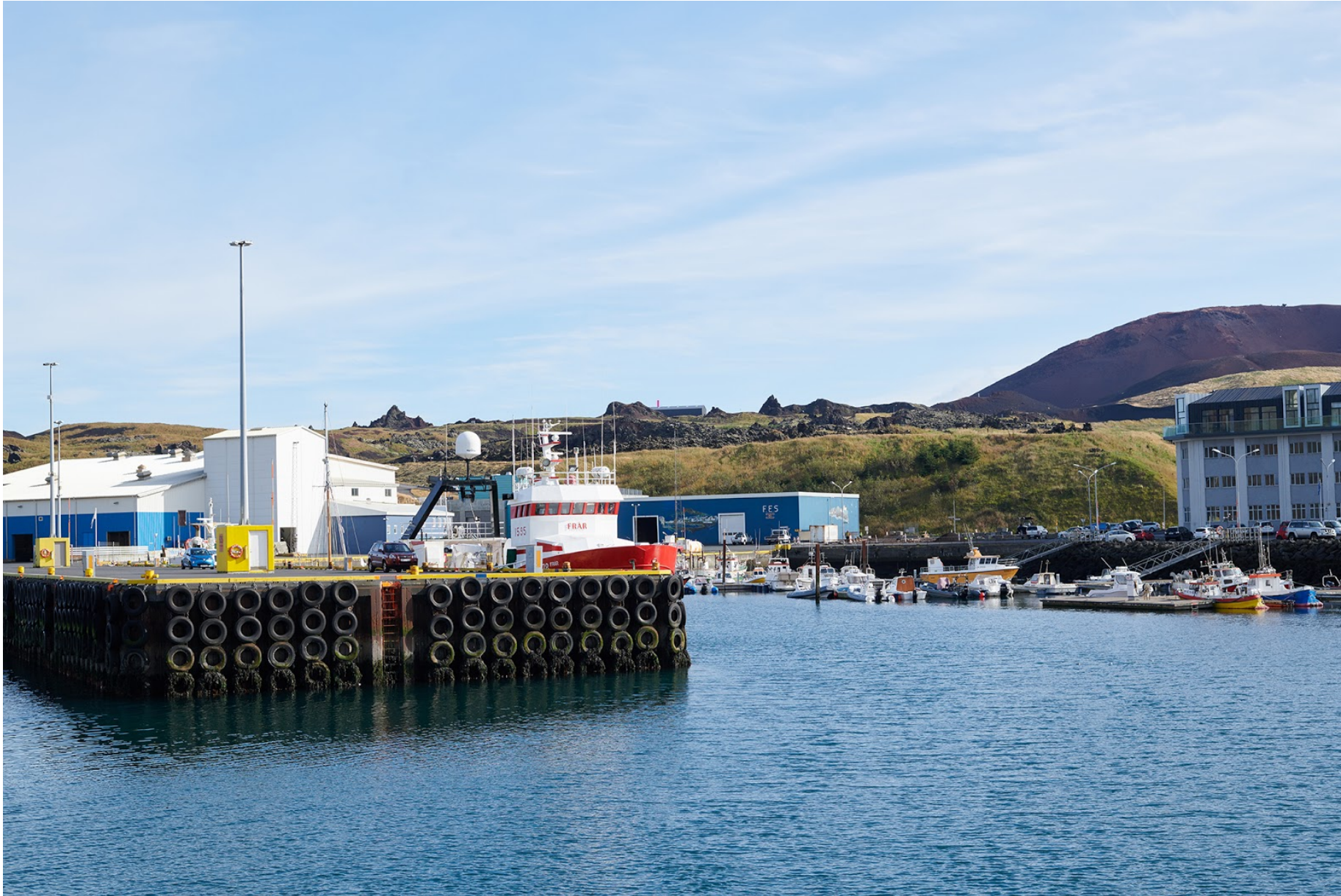
Mynd 3.14. Ásýnd frá höfninni sem gefur vísbandingu um hvaða breytingar verða á ásýnd. Stækkun á húsi sést ekki en nýr strompur sést.
